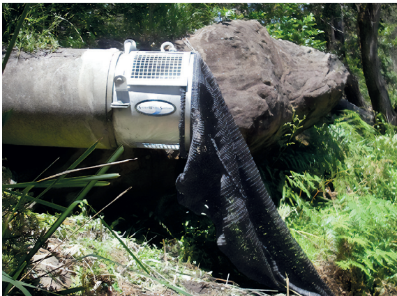
Figura 2: Red que recubre la tubería del alcantarillado
